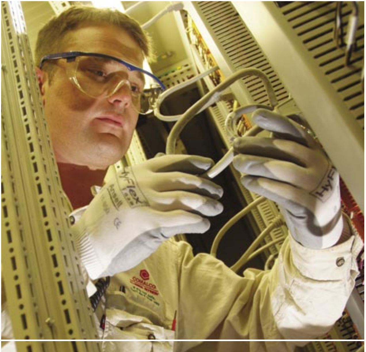
MIE, Comalco Alumina Refinery
